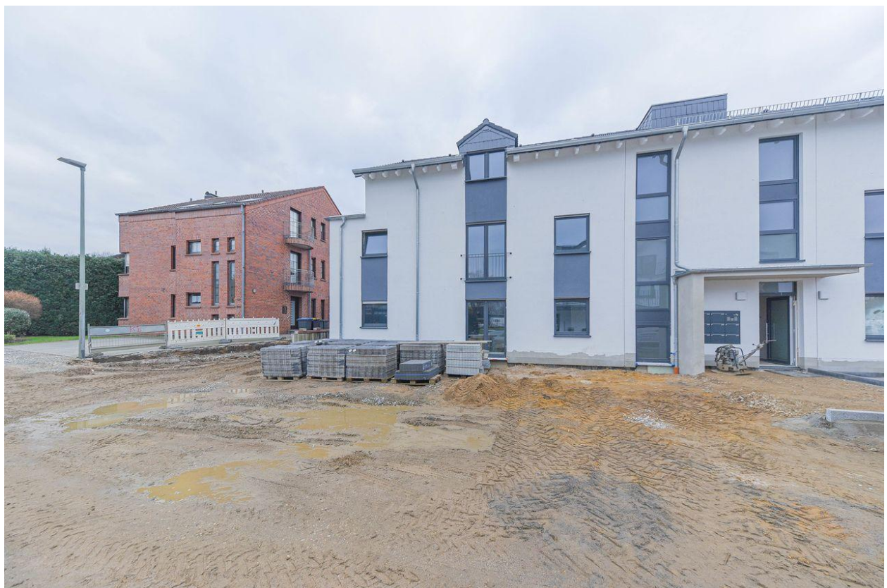
Baustellenfortschritt - kurz vor Fertigstellung
